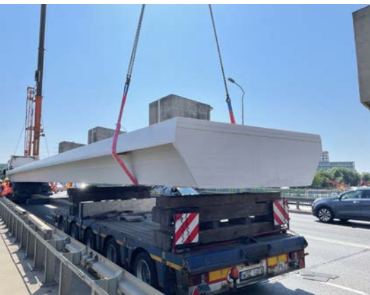
Fot. 2. Montaż przęseł kładki: a) transport przęseł; b) montaż przęseł za pomocą dźwigów; c) wszystkie przęseł kładki na podporach
