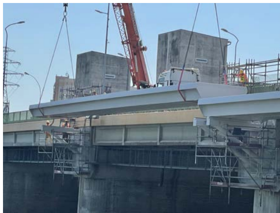
Fot. 2. Montaż przęseł kładki: a) transport przęseł; b) montaż przęseł za pomocą dźwigów; c) wszystkie przęseł kładki na podporach
